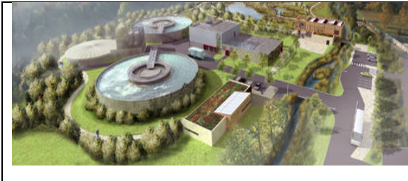
Figure 3 : Vue de synthèse de la station d'épuration d'Ollainville (d'après le portail du conseil régional d'Ile-de-France, consulté le 24 janvier 2008 http://www.iledefrance.fr/lactualite/environnement/environnement/nouvelle-station-depuration-a-ollainville/ )
