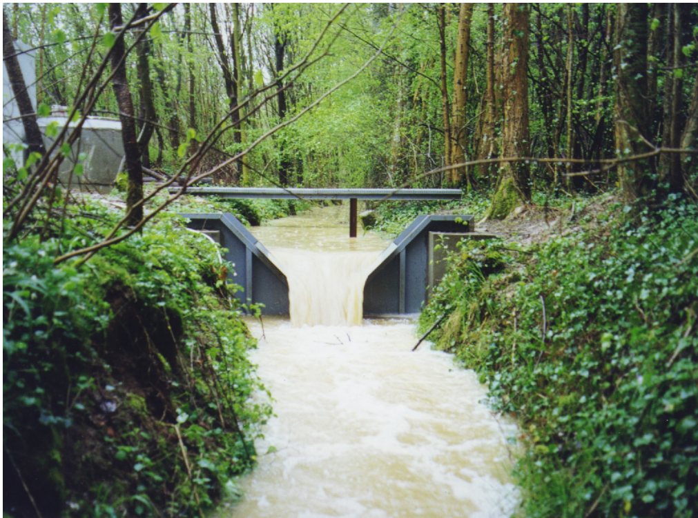
Photographie 1 : station hydrométrique de Choqueuse lors de la crue du 14 avril 1999.
