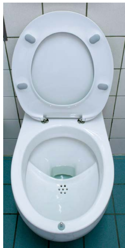
Des toilettes avec séparation de l'urine
